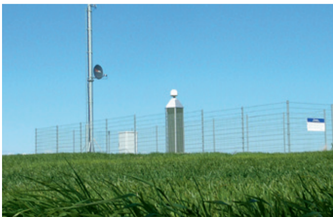
Eine der insgesamt vier Referenzstationen, welche die AXIO-NET beiderseits des Fehmarnbells errichtete.
