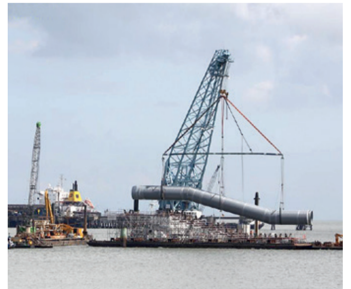
Die Verlegung der Kühlrohre erfolgt mit dem Schwimmkran in bis zu 20 Metern Tiefe. Dennoch lassen sich Genauigkeiten im einstelligen cm-Bereich realisieren.
